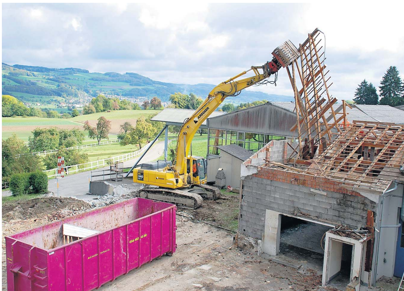
In kurzer Zeit stand keines der vier Gebäude mehr, sie mussten alle dem geplanten Neubau weichen. ZVG
